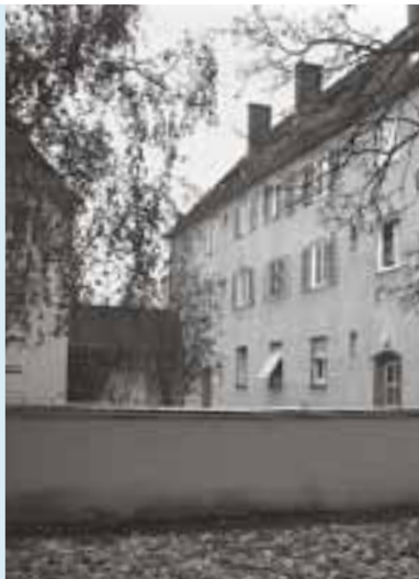
Situation vor der Umbaumaßnahme
