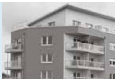
Ginkgo Langen: Ein aufgelockerter Neubau
